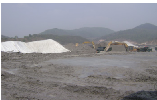
Hình 1. Bãi chứa phế thải tro bay tại nhà máy nhiệt điện Phả Lại – Việt Nam
