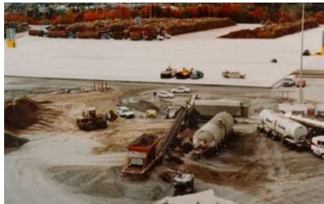
Hình 3. Thi công sân bãi bằng công nghệ BTĐL
