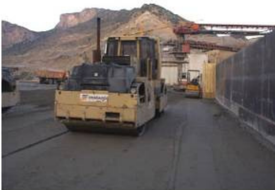
Hình 2. Thi công đập BTĐL bằng xe lu rung ( Beni-Haroun - Algeri)
